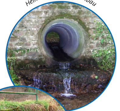
Heimbach vor dem Umbau
